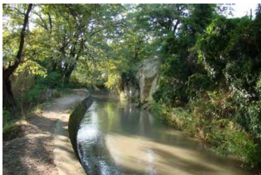
Canal d'irrigation gravitaire à Pertuis
