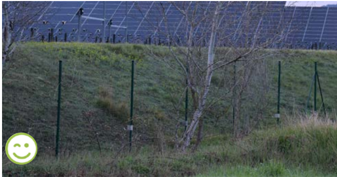
Clôture en pied de talus, plus discrète qu'en crête
