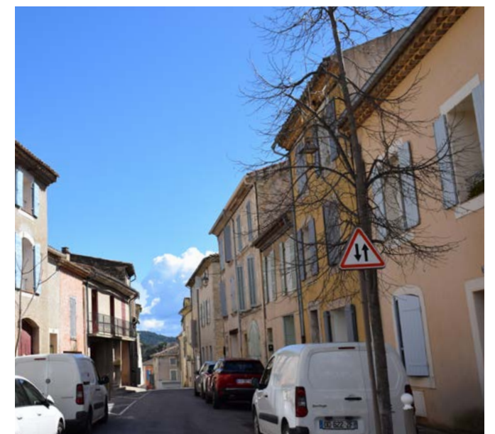
Toitures à investir sur des rues étroites et des villages qui couronnent un relief : ces toitures ne sont pas visibles depuis un point de vue.
