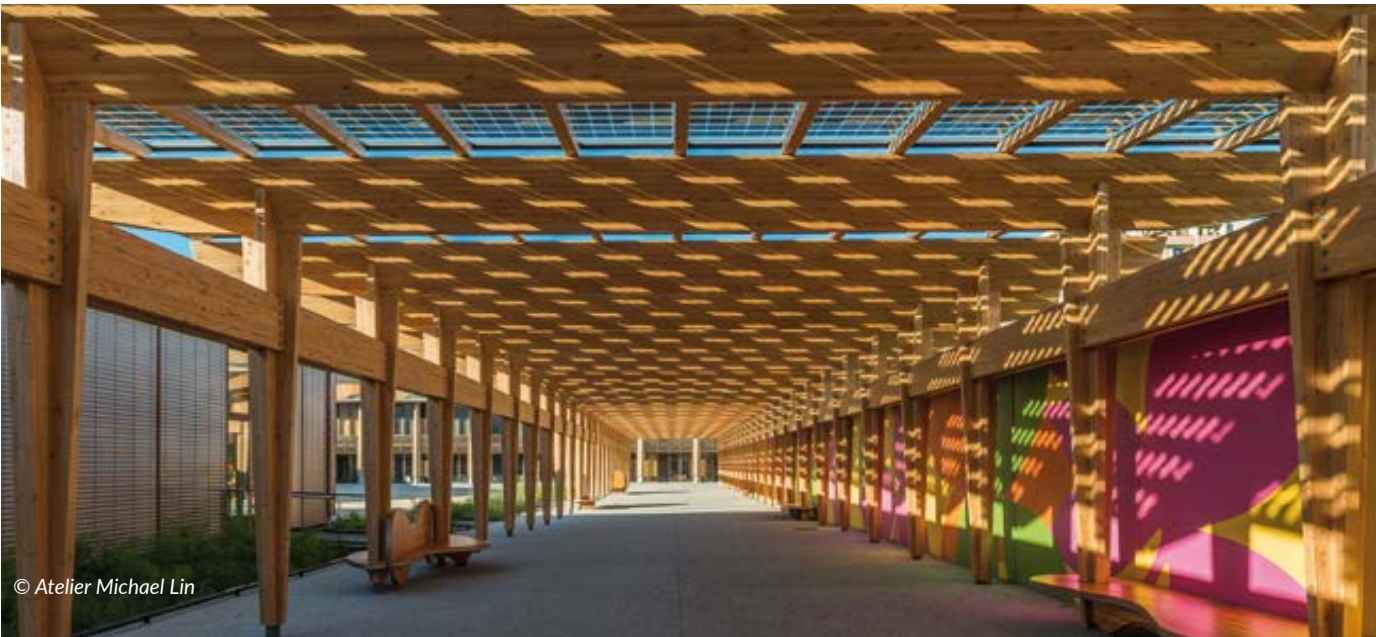
En annexe architecturale : préau de lycée équipé en photovoltaïque (Grenoble)
