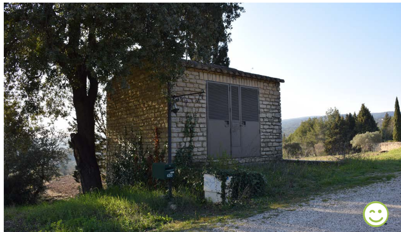
▲ Local technique à Gordes. Accolé à un arbre et d'aspect général soigné : parement en pierres, porte technique de couleur sobre, formes similaires à celles du bâti local (toit à double pente et tuiles canal).
