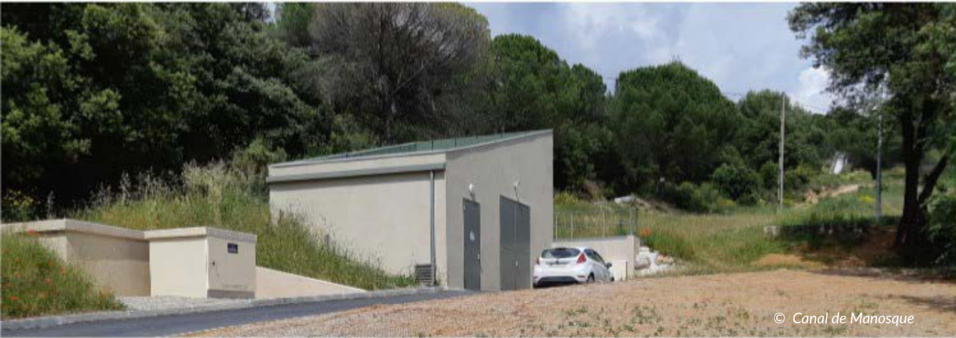
Micro-centrale du canal de Manosque, à Villeneuve
