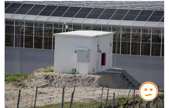
Un local technique mal intégré dans le paysage (couleur et terrassement inadaptés)
