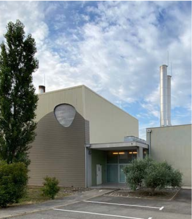
▲ La chaufferie-bois de Manosque
