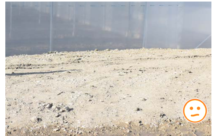
Sol en graviers blancs trop tape-à-l'œil
