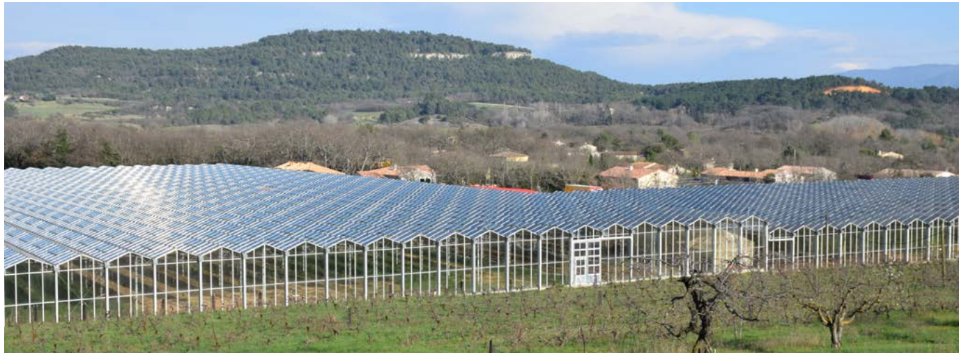
Une serre découpée en plusieurs blocs intégrés dans la pente. Mais trop massive car absence de traversées intermédiaires et de coupure des modules.
