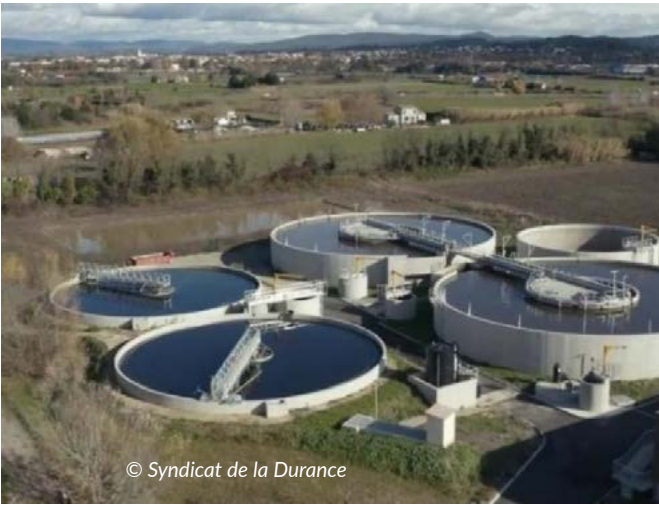
Au-dessus des STEP Ici à Pertuis, qui porte un projet de PV sur sa structure
