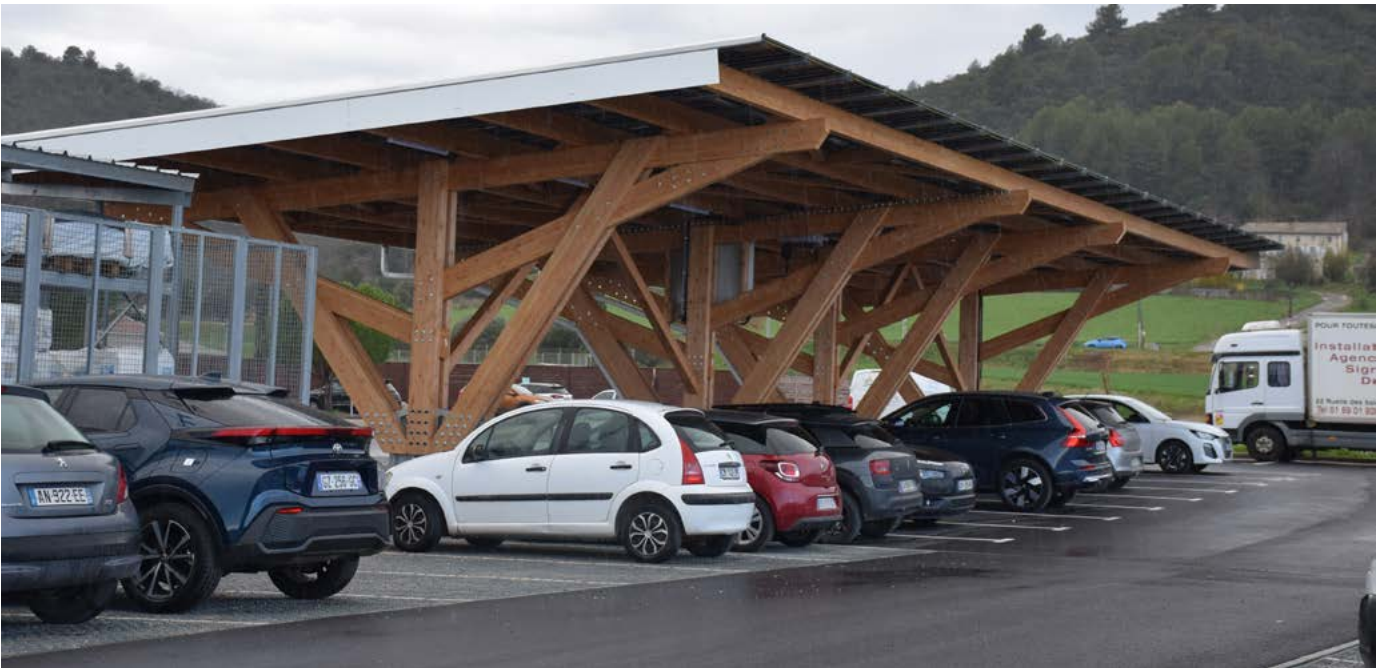
Sur les parkings : ombrière à Manosque
