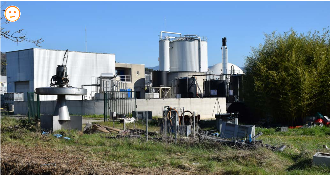
Méthaniseur à Apt : judicieusement installé dans une ZAE, à proximité immédiate du site de production de fruits confits. Néanmoins, les abords sont peu travaillés : une mise en scène de certains dispositifs pourrait être recherchée, dans un objectif pédagogique et paysager
