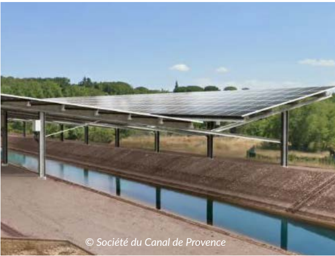
En couverture des canaux Image de synthèse du prototype développé par la société du Canal de Provence
