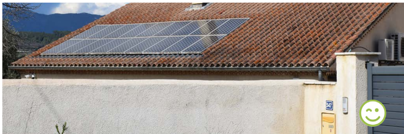
Intégration des panneaux PV dans la toiture
