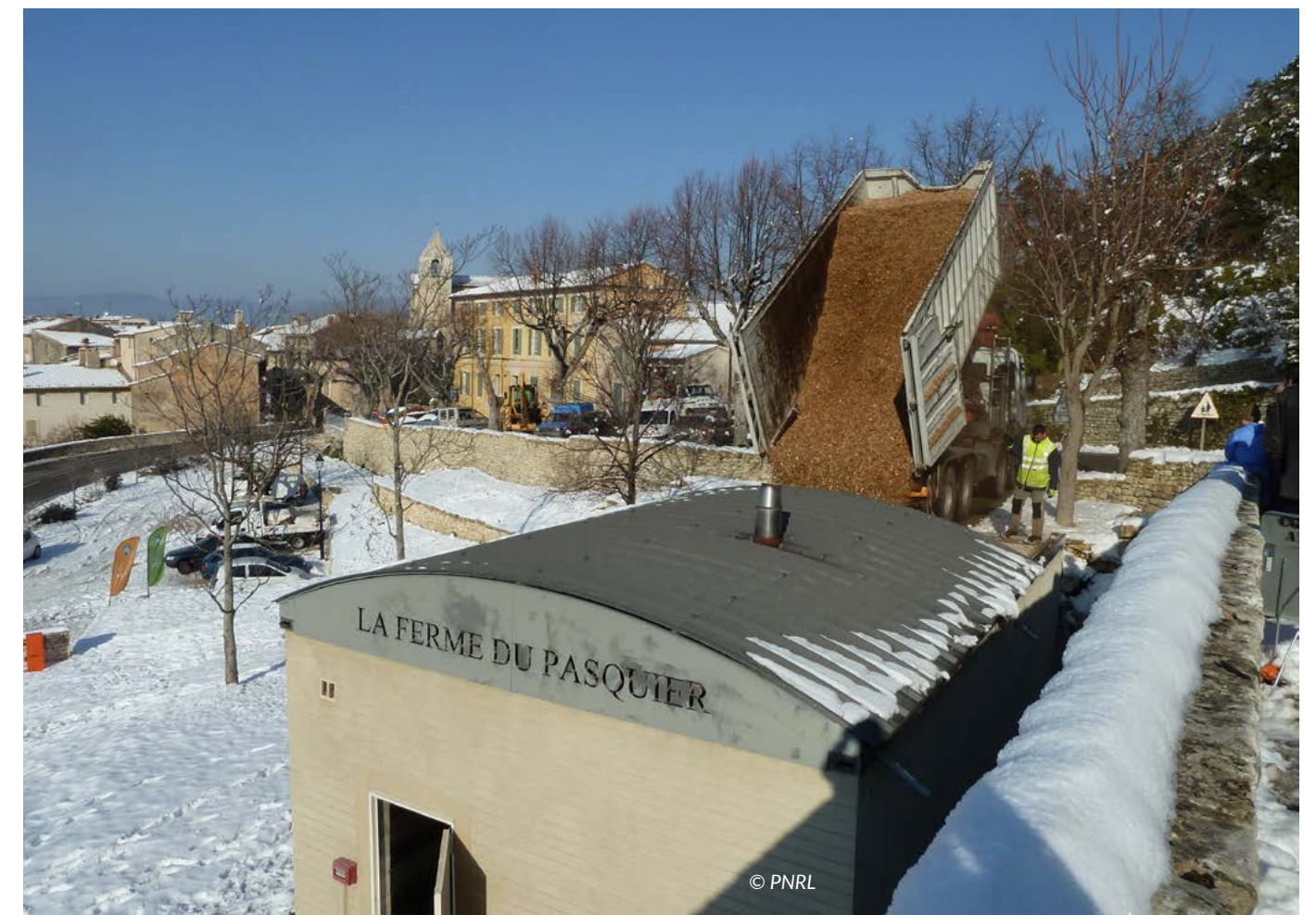
Réseau de chaleur communal et chaufferie-bois "La ferme du Pasquier" à Saignon (84)
