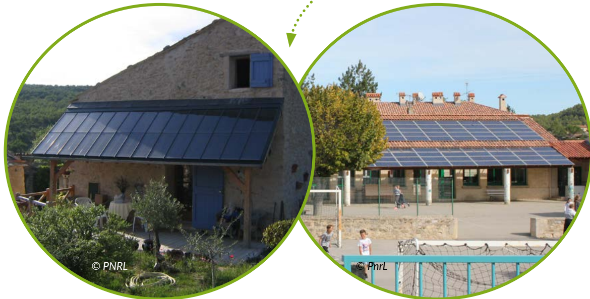
Auvent photovoltaïque à Saint-Michel-l'Observatoire
