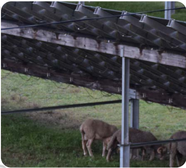
Exemple de structure de panneaux partiellement en bois à Sainte-Tulle. Gestion extensive par le pâturage.
