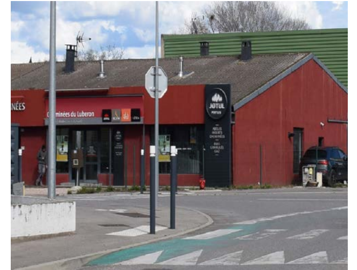
Toitures des bâtiments d'activités en éternit à remplacer
