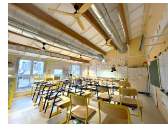
Amélioration des perf énergétiques et du confort intérieur de l'école
