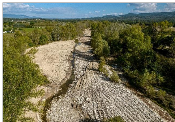
Site de la Pérussièrre après travaux © SIRCC
