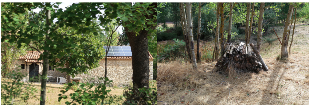
Installation solaire en toiture, Le village
