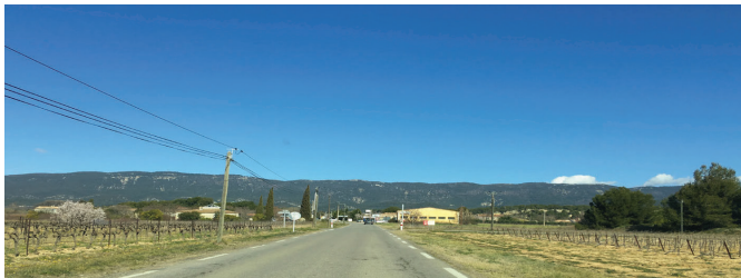
Route de l'étang de la Bonde : existant
