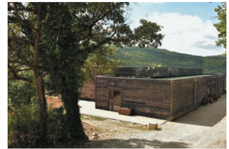
Exemple de valorisation de bois certifié : Salle des fêtes Pierre Martel à Aubenas-les-Alpes
