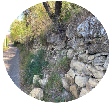
Un mur en pierre sèche qui marque l'identité rurale du lieu, à restaurer
