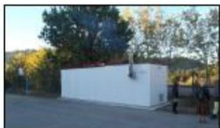
La chaudière proposée qui assurait le chauffage d'une partie des bâtiments a été conservée et sert d'appui à la chaudière bois lors des périodes de grands froids et assure également le secours dans le cas où la chaudière bois ne serait pas fonctionnelle.
