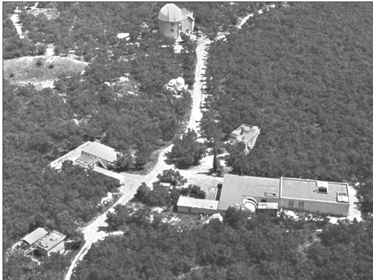
Photo 1 : deux bâtiments de l'Observatoire de Haute Provence abritent les instruments de la station Géophysique : dans le bâtiment principal sont installés les lidars (trappes et cimier de coupole ouverts), dans le petit bâtiment voisin est installé le spectrophotomètre Dobson. Au fond la coupole abritant le télescope de 152 cm.
