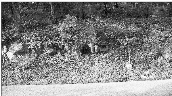
Photo 4 : vue du four sur le bord de la route, on distingue à peine une partie de la paroi.
