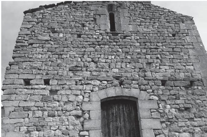
Fig. 12 : l'alignement horizontal d'orifices.
