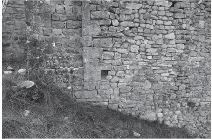
Fig. 14: le chaînage extérieur désignant la construction ancienne.
