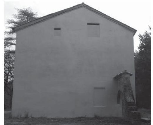
Fig. 4 : façade Ouest après travaux. Photo: S. Bourlon
