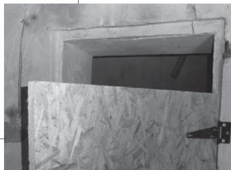
Fig. 5 : porte dans la pièce N, après travaux. Photo : M. Berson
