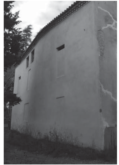
Fig. 2 : façade Sud après travaux. Photo: S. Bourlon
