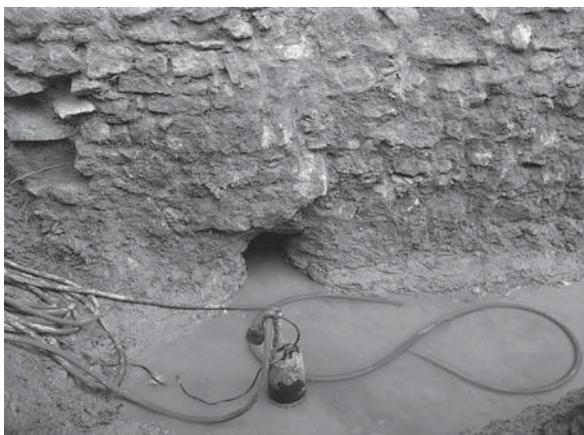
Fig. 28: le collecteur principal au fond du drain.
