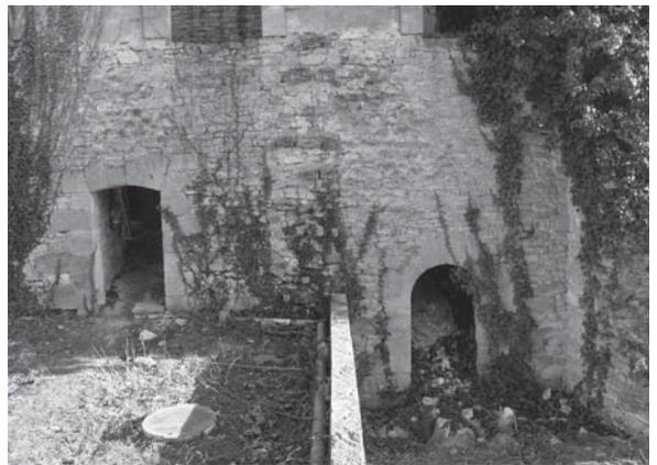
Fig. 20: détail du soubassement (chaînage en attente).
