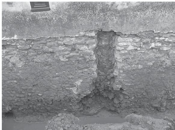
Fig. 27: le conduit d'évacuation des eaux de toiture.
