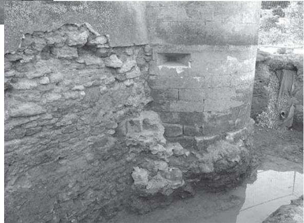
Fig. 24 : la base de la tour fondée et renforcée par le chemisage.
