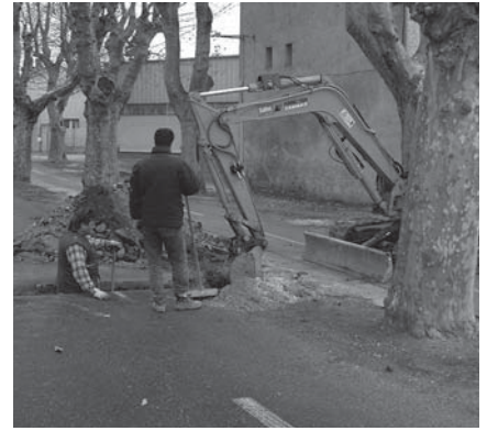
Travaux de tranchée entre platanes
