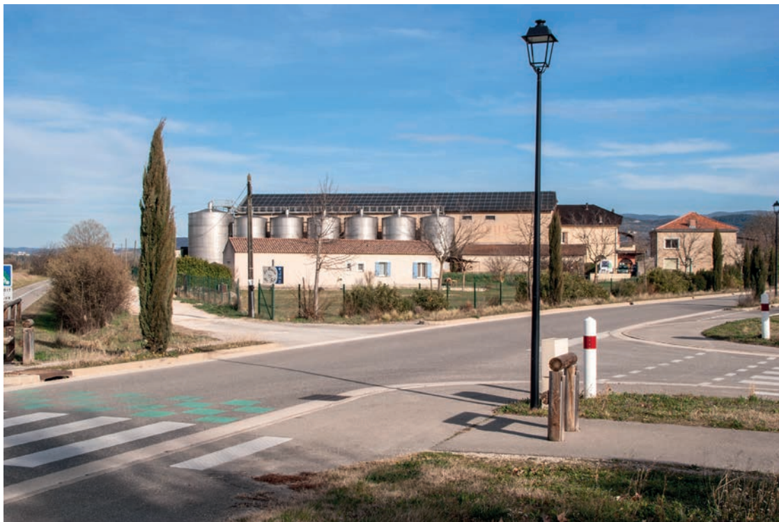
Panneaux photovoltaïques sur le toit de la cave coopérative de Bonnieux.
