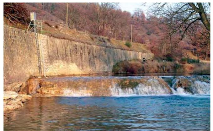
Station de mesure des débits sur le Calavon à Coste Raste
