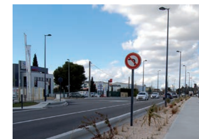
Rénovation de l'éclairage public par la Communauté d'agglomération Luberon Monts de Vaucluse
