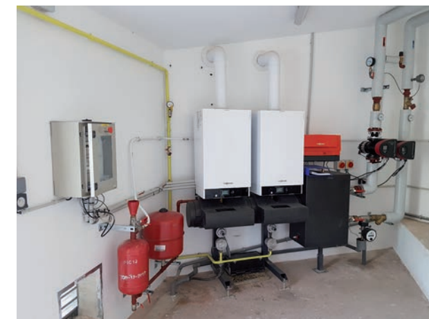
Rénovation de la chaufferie de l'école de Gargas
