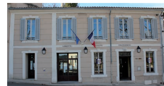
Travaux de chauffage dans la mairie d'Ansouis
