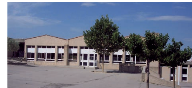
Rénovation des menuiseries de l'école à Volx
