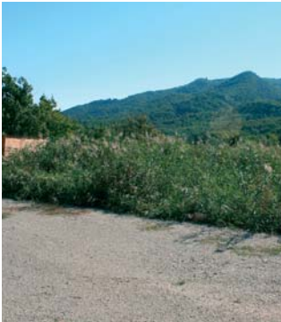
Nouvelle station d'épuration de Saint-Maime Lits plantés de roseaux
