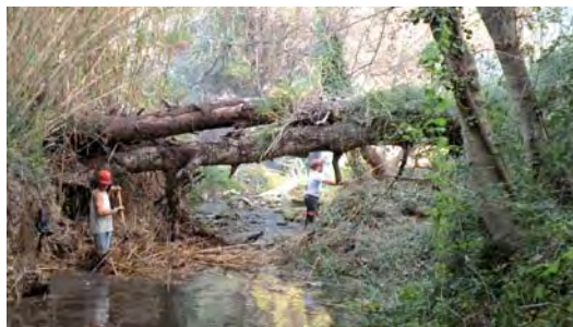
Travaux d'entretien de la rivière
