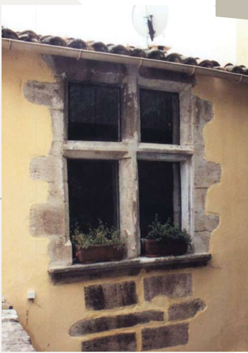
Les effets du séisme de 1708 sur le bâti: 1. Claveaux de fenêtres descendus à St-Martin-les-Eaux (04). 2. Appui de fenêtre fendu dans le village de St-Martin-les-Eaux (04). 3. Fenêtre renaissance au meneau central brisé et déplacé dans le village de Dauphin (04). © Georgia POURSOULIS.
