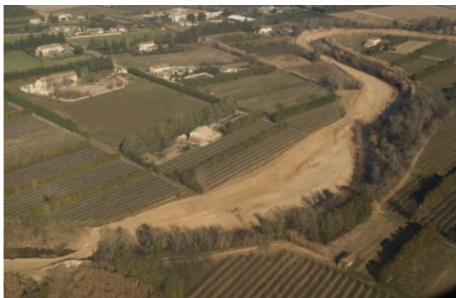
Photo 48 : Travaux du PACC dans le secteur du Petit Grès – PNRL, J. BRICHARD
