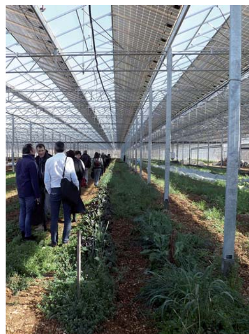
Visite de serres solaires photovoltaïques à Saint-Saturnin-lès-Apt
