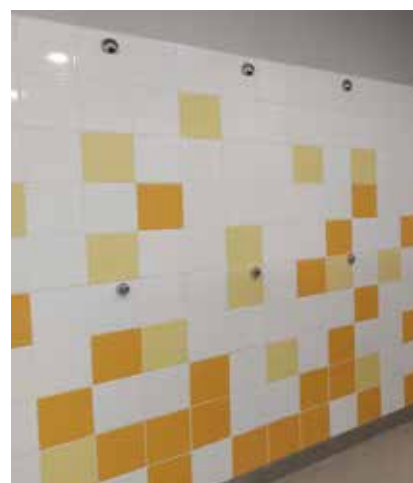
Douches du gymnase après travaux
