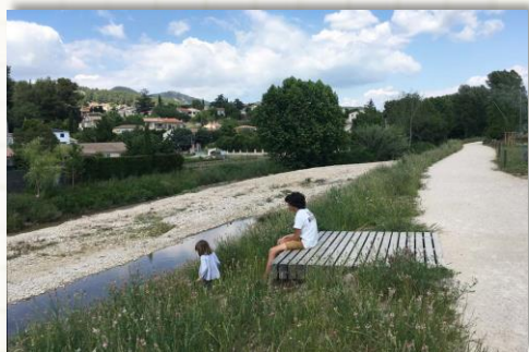
Restauration d'un cours d'eau urbain, Auriol, EPAGE HUCA
