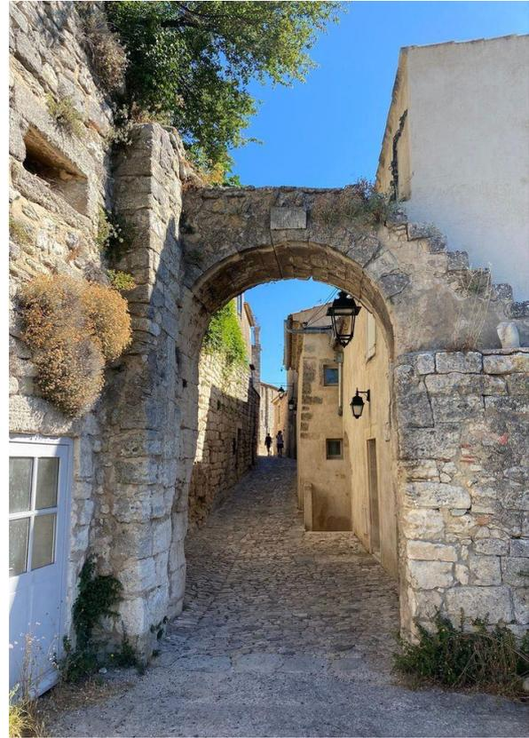
Des dégradations inquiétantes ont été relevées : éléments altérés, envahis par la végétation destructive, l'usure du temps, pierres descellées.
