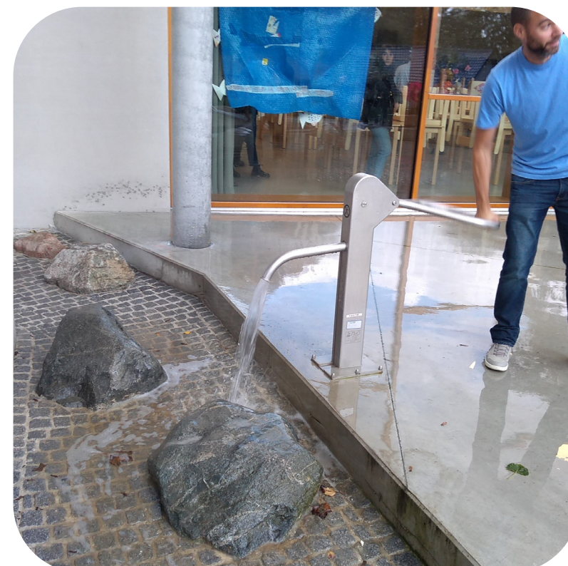
Une pompe d'où coule l'eau de pluie récupérée dans un bassin enterré
