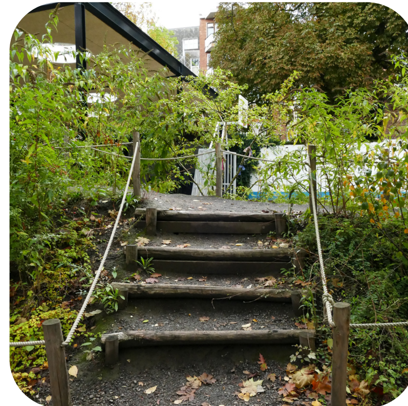
Des marches en bois pour un escalier sur une butte de terre
