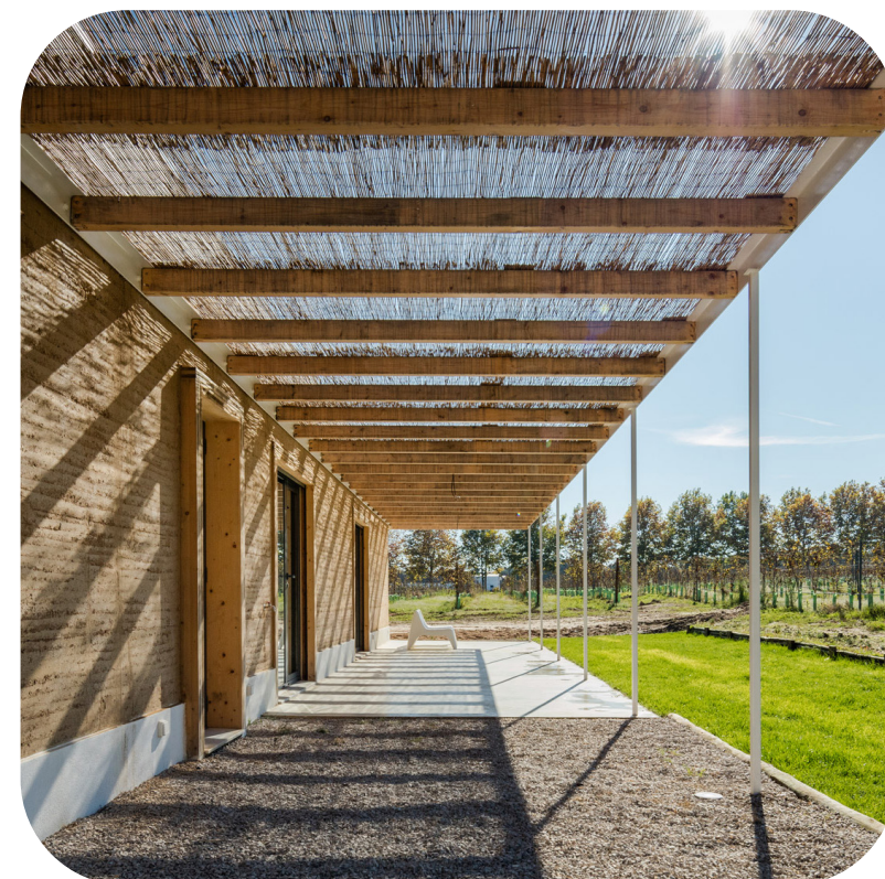
Un auvent en paillage pour se mettre à l'ombre et rafraîchir la façade
