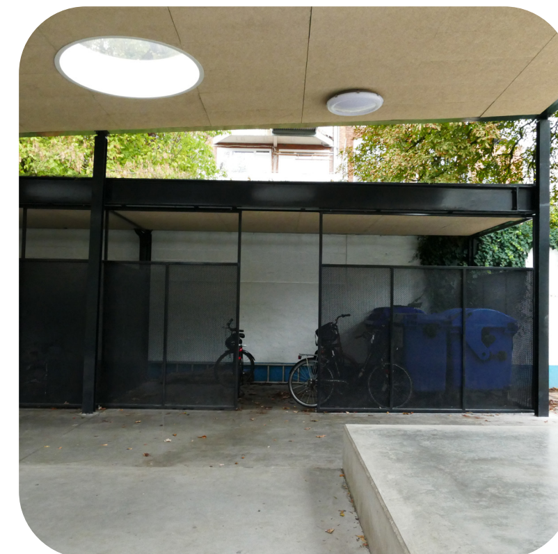
Un garage à vélos ouvert sur un préau
