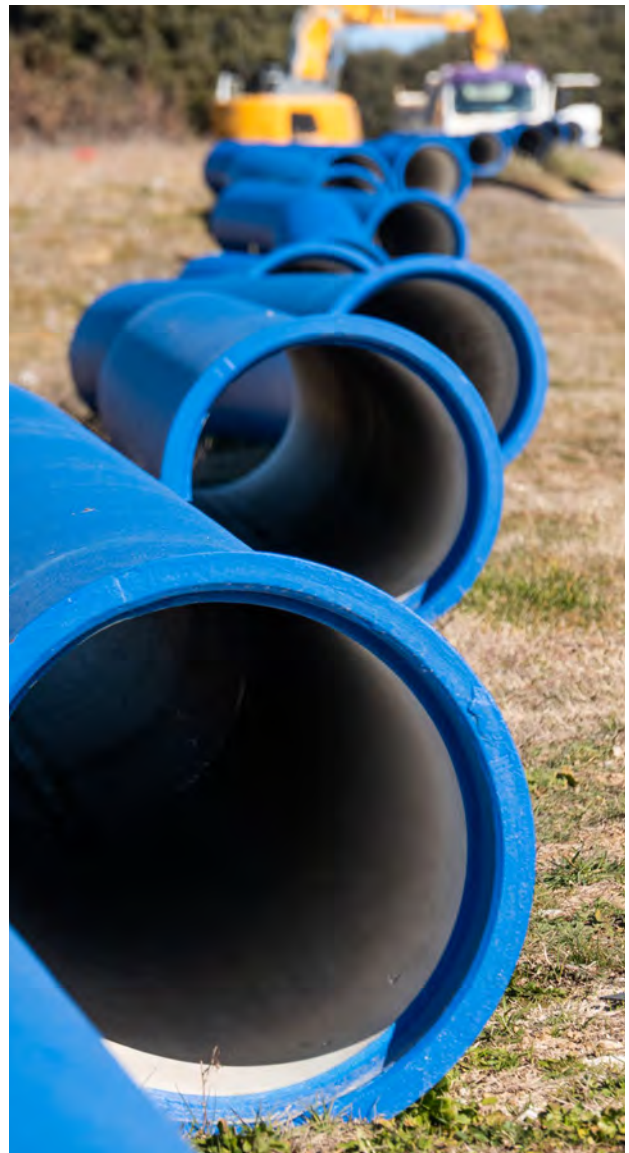
Tuyaux prêts à être enterrés pour transporter l'eau © SCP
