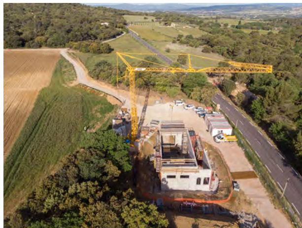
Réalisation de travaux pour la station de pompage du canal de Provence mise en service en 2024 sur la commune de Mirabeau (84) © SCP
