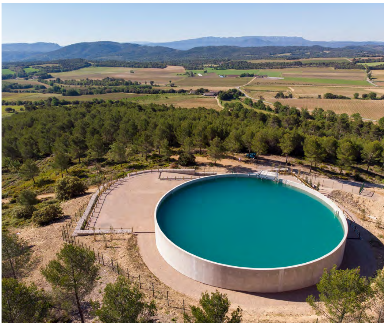
Réservoir du canal de Provence mis en service en 2024 sur la commune de Mirabeau. © SCP
