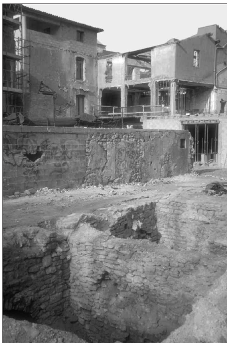
Fig. 2 : vue générale du site de Saint-Georges (au second plan, chantier de construction du futur musée de l'Aventure industrielle).
