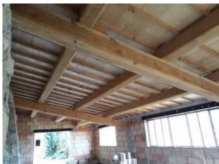
MG Construction/la Forestière de Provence , Ossature traditionnelle en cèdre Corps de ferme Venasque
