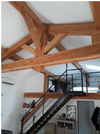
MG Construction/la Forestière de Provence , Ossature traditionnelle en cèdre Corps de ferme Venasque
