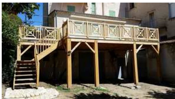
Ossature, balcon, rambarde et escalier
