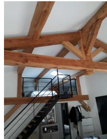
MG Construction/la Forestière de Provence , Ossature traditionnelle en cèdre Corps de ferme Venasque
