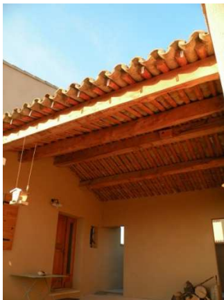
Thibaud Aubert , Les Taillades, charpente d'appentis en cyprès
