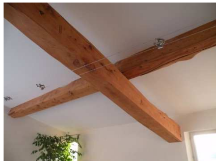
Thibaud Aubert , Les Taillades, charpente intérieure en cyprès
