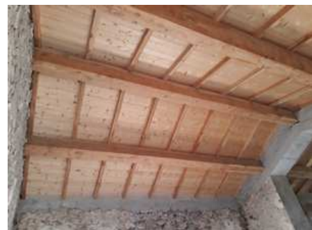
MG Construction/la Forestière de Provence , Ossature traditionnelle en cèdre Corps de ferme Venasque
